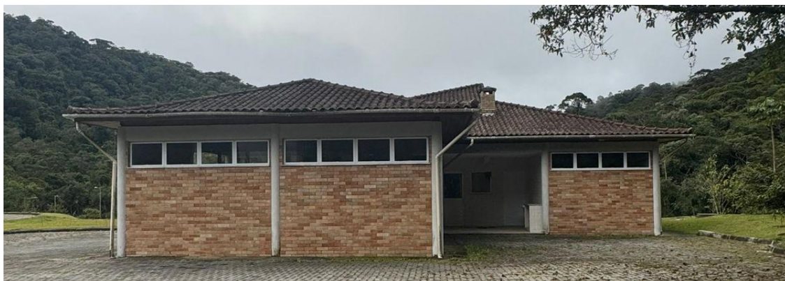
Figura 4 - Banheiro de visitantes
