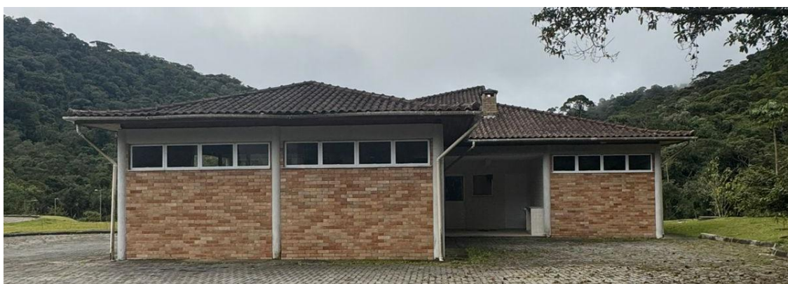
Figura 4 - Banheiro de visitantes
